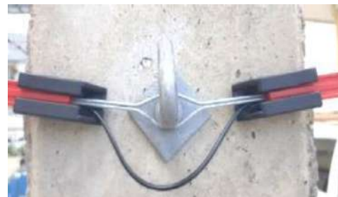
อุปกรณ์จับยึดสายกระจายแนวตรง (Nylon-62)
